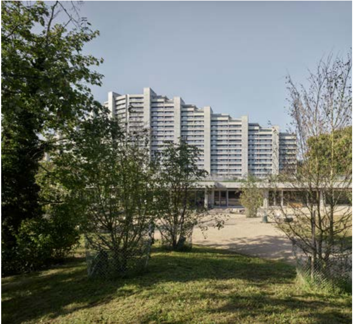
Energetische Sanierung Telli B & C, Aarau (©Karin Gauch, Fabien Schwartz)
